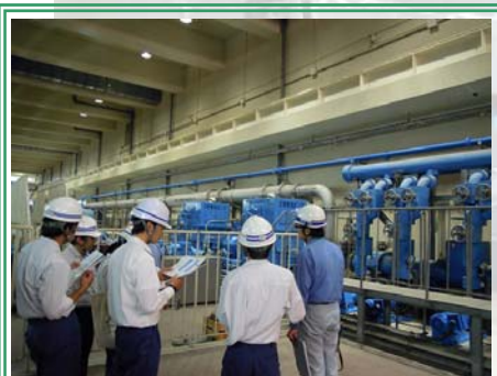
浄水処理設備の説明を受ける研修生
